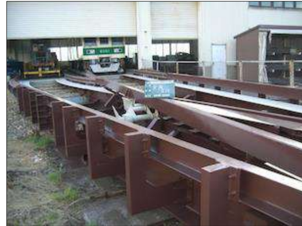
神戸新交通ポートアイランド線 車両基地内分岐器
